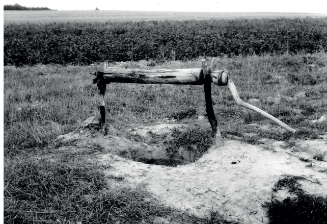
Fig. 6. Szybik garncarski z kołowrotem, okolice Góry Pasiecznej, Chałupki, stan z roku 1984, fot. J. Fijałkowski (MNKi/Pf/1903) • Pottery pit with a turnstile near the Pasieczna Hill, Chałupki, status from 1984, photo J. Fijałkowski (MNKi/Pf/1903)
