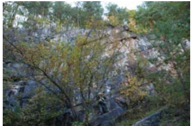
Fot.4. Zachodnia ściana Kamieniołomu Szewce na Górze Okrąglice Figure 4. Western wall of the Szewce quarry in Okrąglice mountain Fot.: G. Pabian
