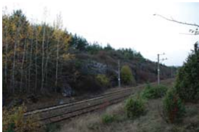
Fot.7. Widok na przekop kolejowy w Kowala Figure 7. View at railway crosscut in Kowala
