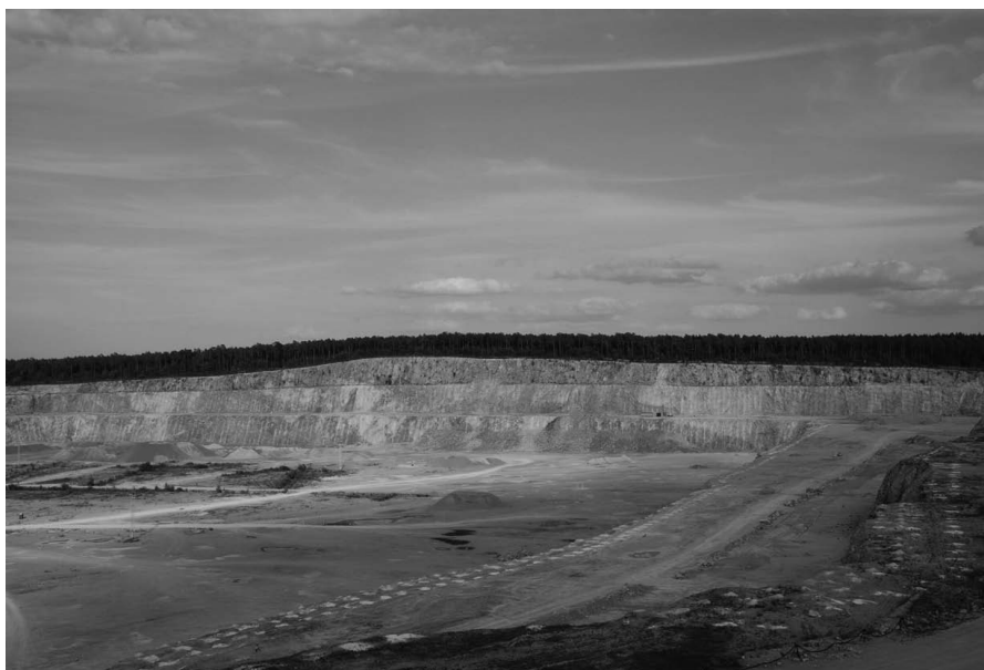
Fot. 2. Widok na południowo-wschodnią część kamieniołomu „Trzuskawica”. Fot. G. Pabian, 2012 Photo 2. View at the south-eastern part of “Trzuskawica” quarry. Photo by G. Pabian, 2012
