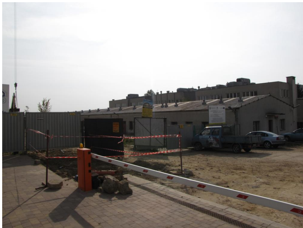
FOT.7 Widok północno – zachodni ( ZDJĘCIE – AUTOR)
