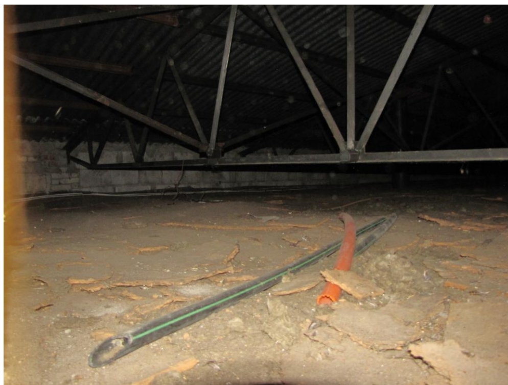
FOT.16 widok warstwy wykończeniowej sufitu podwieszonego ( ZDJĘCIE – AUTOR)
