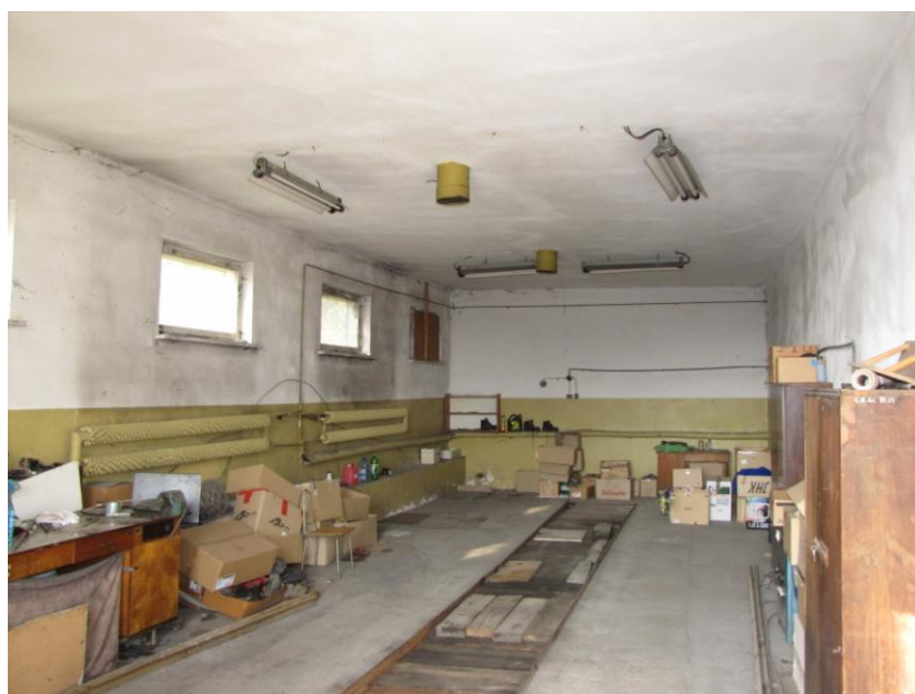
FOT.14 Pomieszczenie garażowe( ZDJĘCIE – AUTOR)
