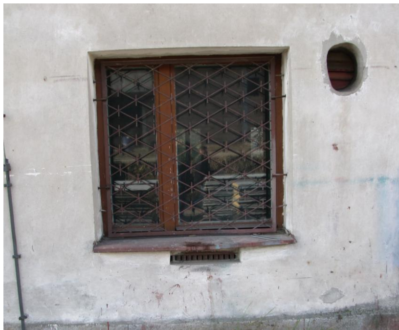
OK-2 - Okno drewniane z kratą stalową
