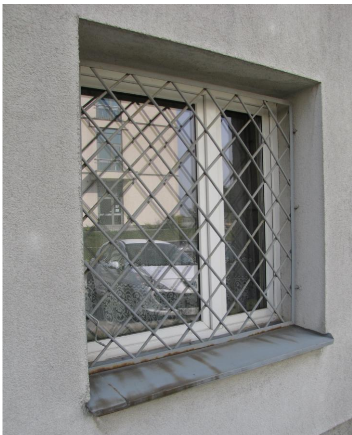
OK-1 - Okno PCV z kratą stalową
