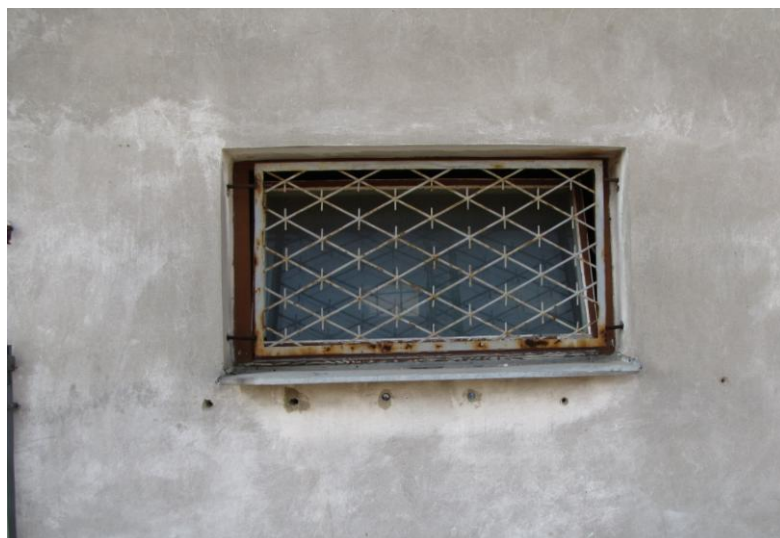
OK-3 - Okno drewniane z kratą stalową
