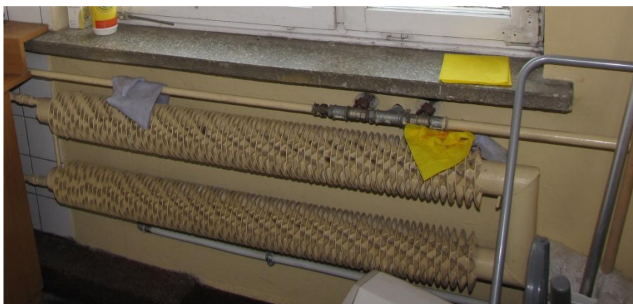
Grzejnik G1 - stalowy rurowo-żebrowy
