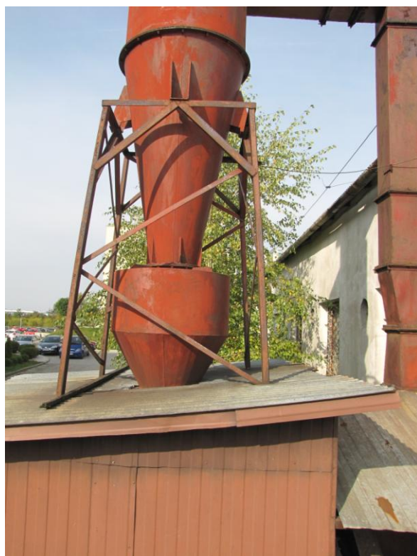
FOT.4 Elewacja południowa – urządzenie do demontażu( ZDJĘCIE – AUTOR)
