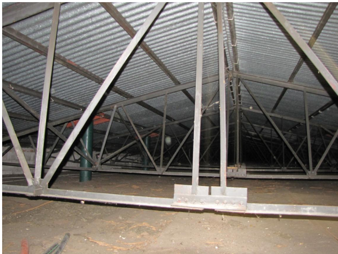
FOT.15 widok konstrukcji stalowej przekrycia ( ZDJĘCIE – AUTOR)
