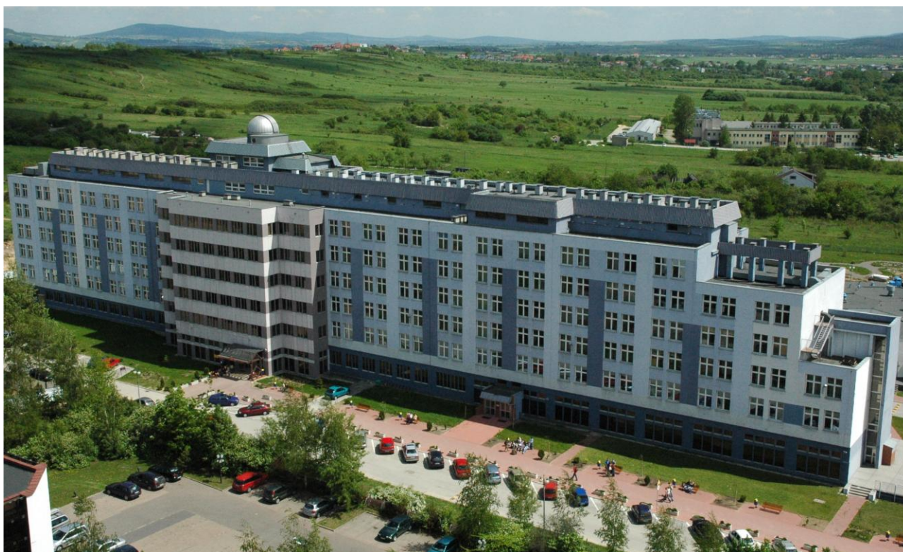
Fotografia 2 Widok na istniejący budynek A Wydziału Matematyczno-Przyrodniczego UJK
